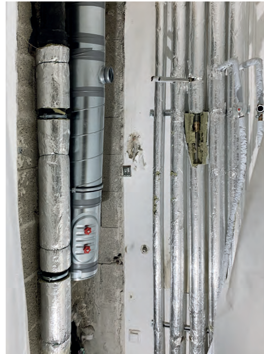
Der vorhandene Lüftungsschacht zwischen Bad und Toilette in den betroffenen Wohnungen musste erneuert werden.
