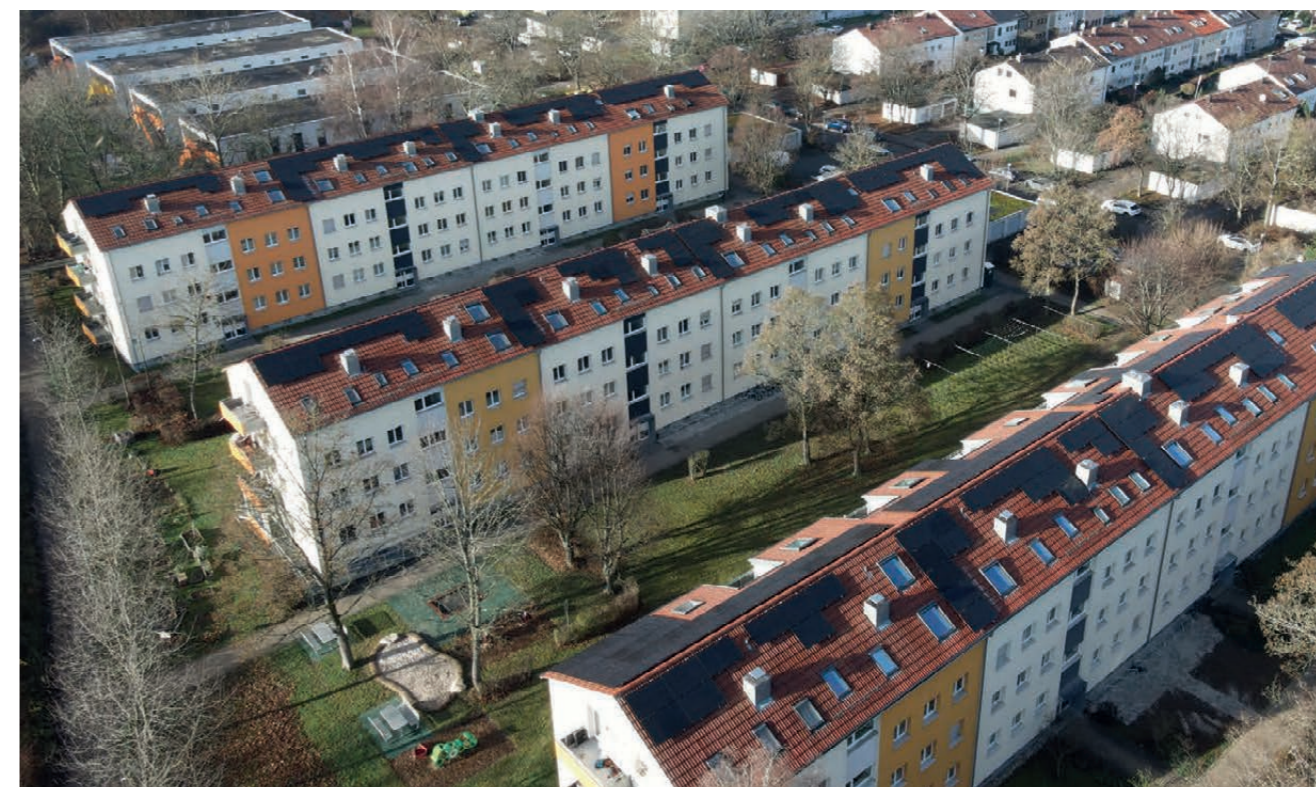
PV-Anlagen auf den Dächern
