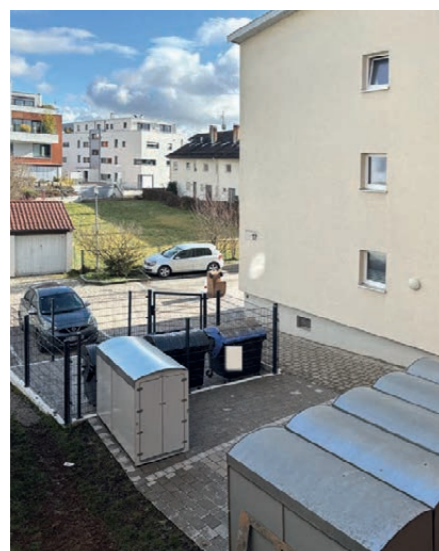
Neue Fahrradboxen und neuer Müllplatz in der Kanalstraße in Leinfelden-Echterdingen
