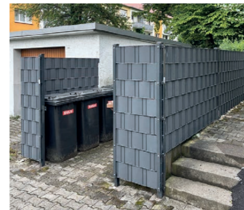
Neuer Müllplatz im Orionweg in Stuttgart
