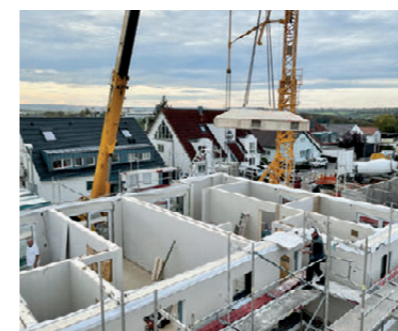
Anlieferung und Aufbau von vorgefertigten Holzbauteilen
