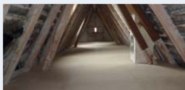
... und danach. So isoliert, geht keine Energie mehr verloren.
