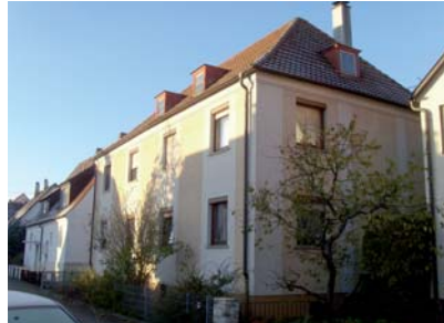
Am Klebwald: Vor der Modernisierung
