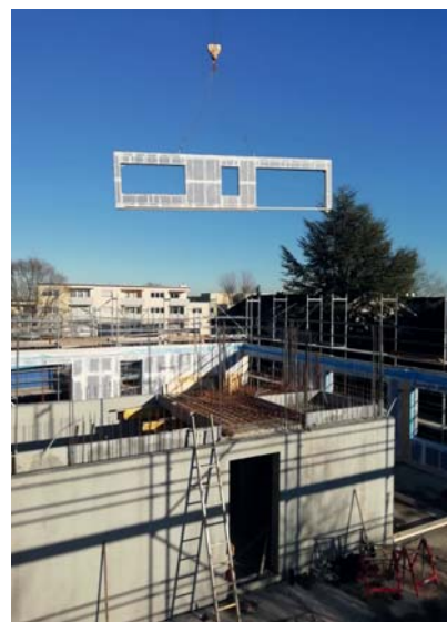
Ganze Wände werden am Stück eingesetzt.
